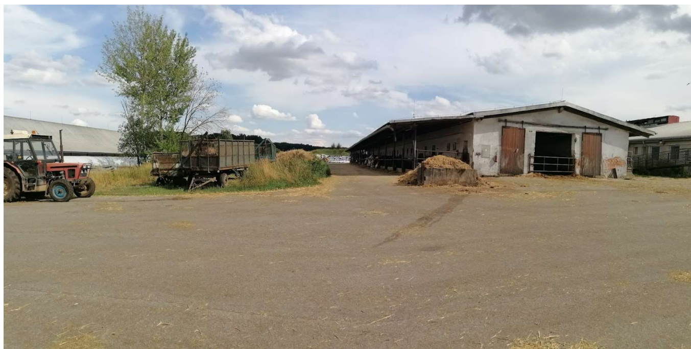
Severozápadní pohled na místo výstavby stáje č. 6
